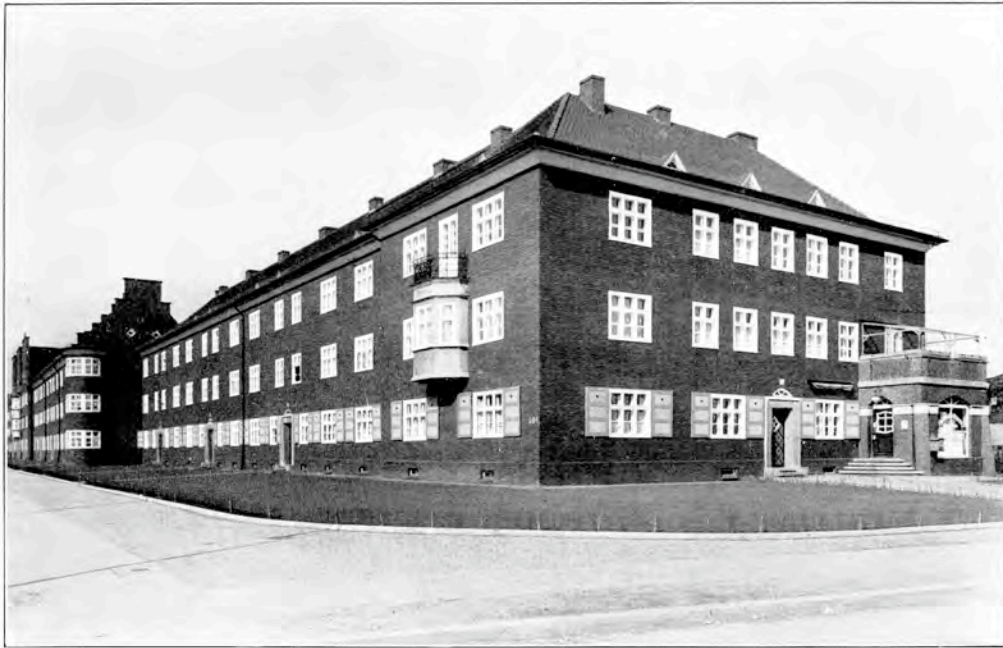
Siedlung der Berliner städtischen Gaswerke, Berlin-Lichtenberg, Blockdammweg. Architekt: Engelmann.
