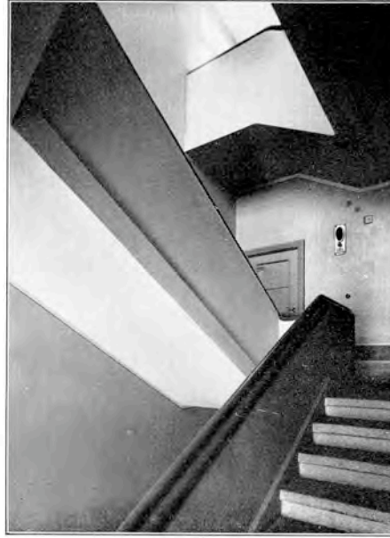
Gemeindehaus der Zwingli-Gemeinde. Treppenhaus.
