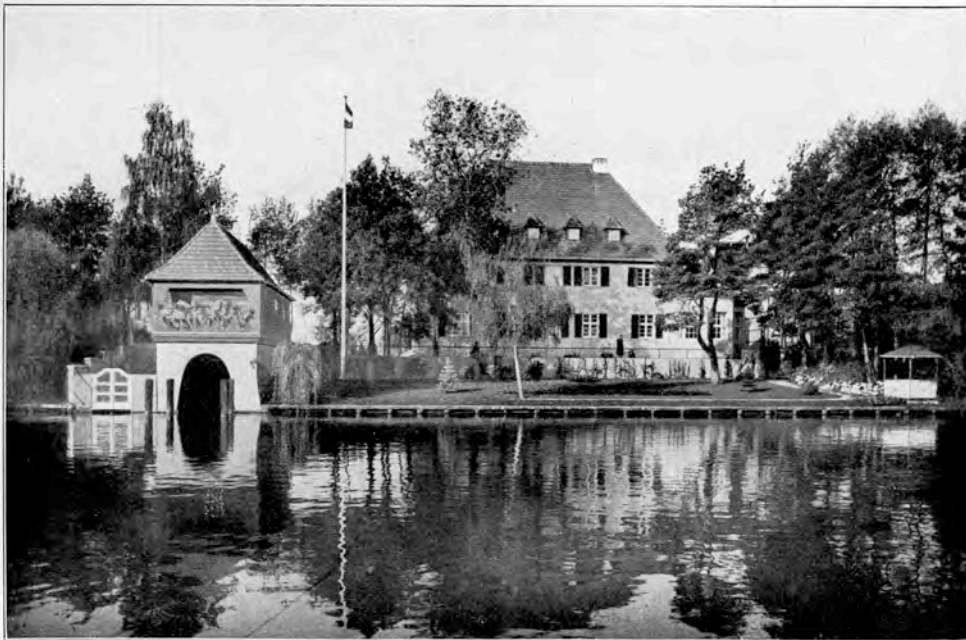
Haus Geyer, Zeuthen. Wohnhaus und Bootshaus. Architekt: Prof. Otto Rud. Salvisberg.
