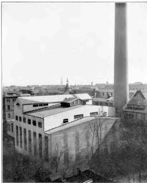
Elektrizitätswerk und Kesselhaus der Reichsdruckerei, Berlin. Entwurf: Bauverwaltung der Reichsdruckerei. Architekt: Karl Gottwaldt.
