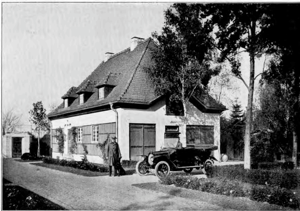
Haus Geyer. Garage.
