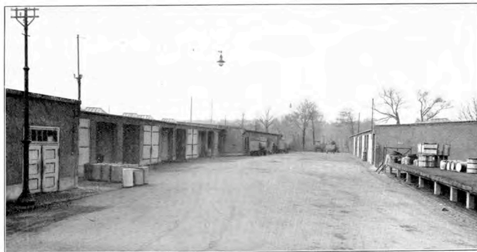
Olex-Garagen, Rummelsburg, Tankanlage Nobelshof. Hofansicht.
