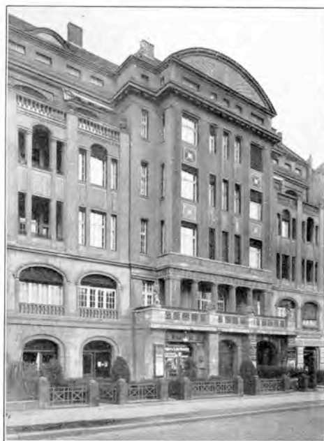
Wohnhaus Holdheims Hof, Berlin, Kottbuser Ufer. Architekten: Kristeller & Sonnenthal.
