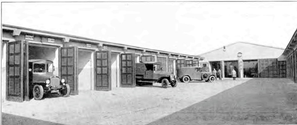
Ullsteingaragen, Tempelhof. Hofansicht.
