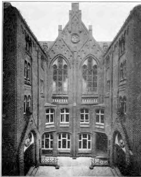
Erlöser-Kirche, Berlin. Architekt: George Pouroy.
