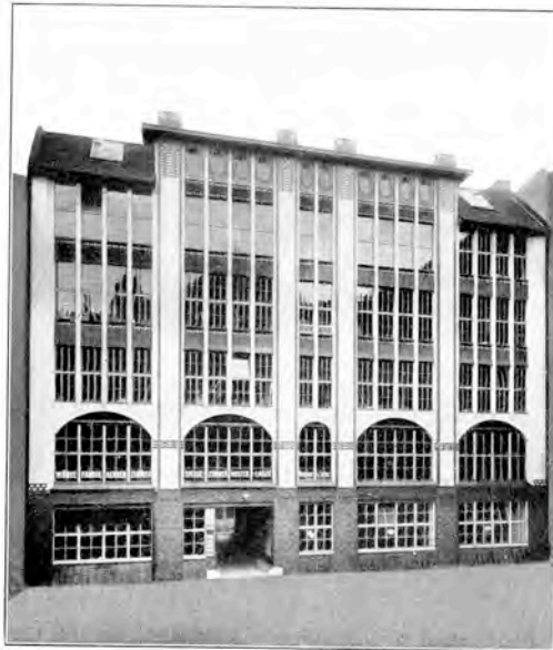
Fabrikgebäude Frankfurter Allee 57. / 322 Architekt: Hans Liepe.
