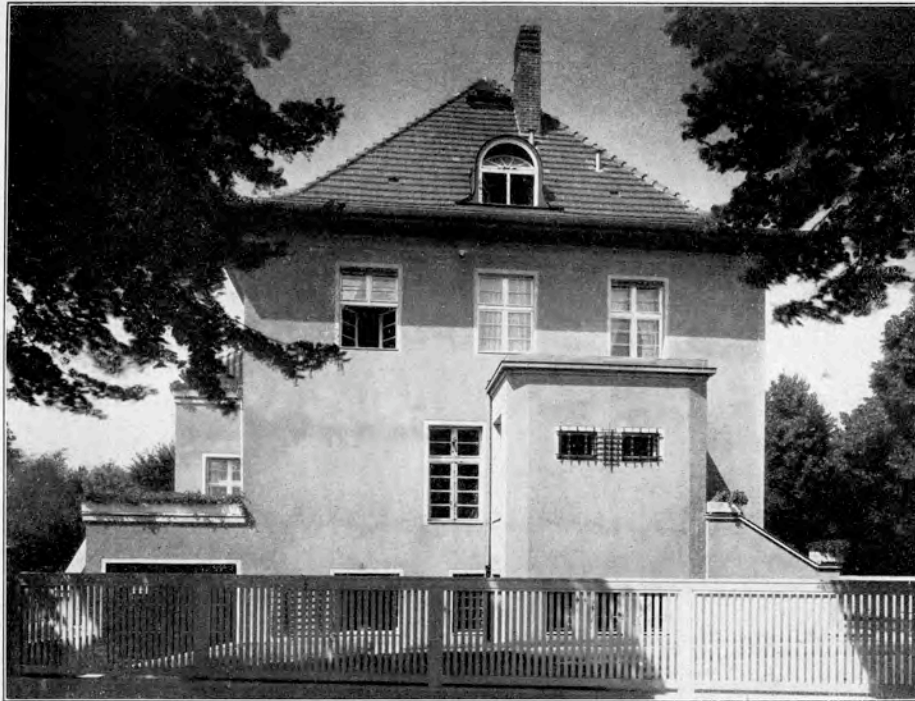
Doppelwohnhaus Dahlem, Limonen- Ecke Malvenstraße. Architekt: Herbert Ruhl, in Terrasit geputzt. Seitenansicht.
