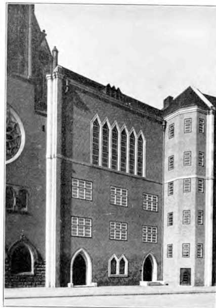
Gemeindehaus der Zwingli-Gemeinde, Berlin. Straßenfront. Architekt: Reg.-Baumeister Fritz Buck.
